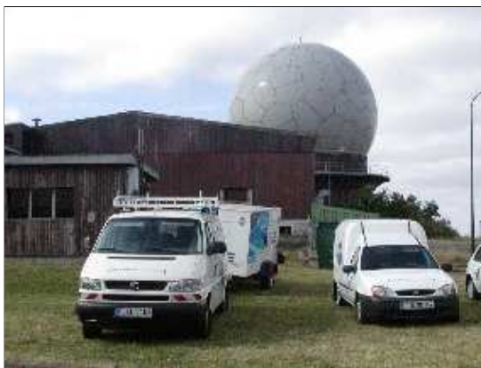
Auf Hessens höchstem Berg wurde heute das neue Blockheizkraftwerk in Betrieb genommen...
